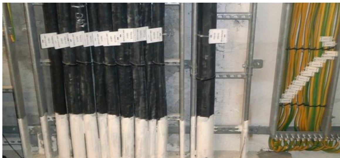
Рис. 4. Пример маркировки кабелей
