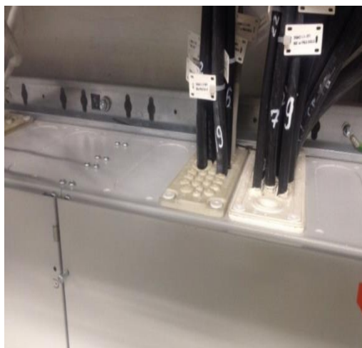
Рисунок 3 – Ввод кабеля через мембранный кабельный ввод
