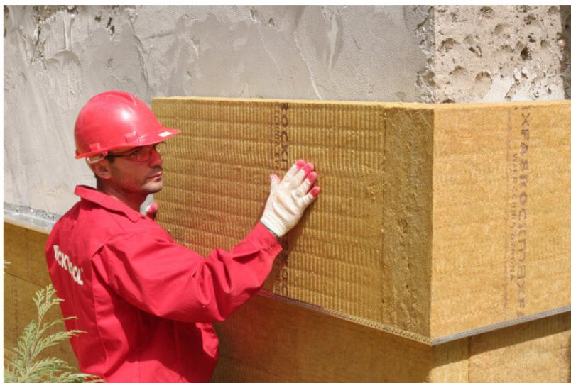
Рис. Устройство утеплителя первого яруса
